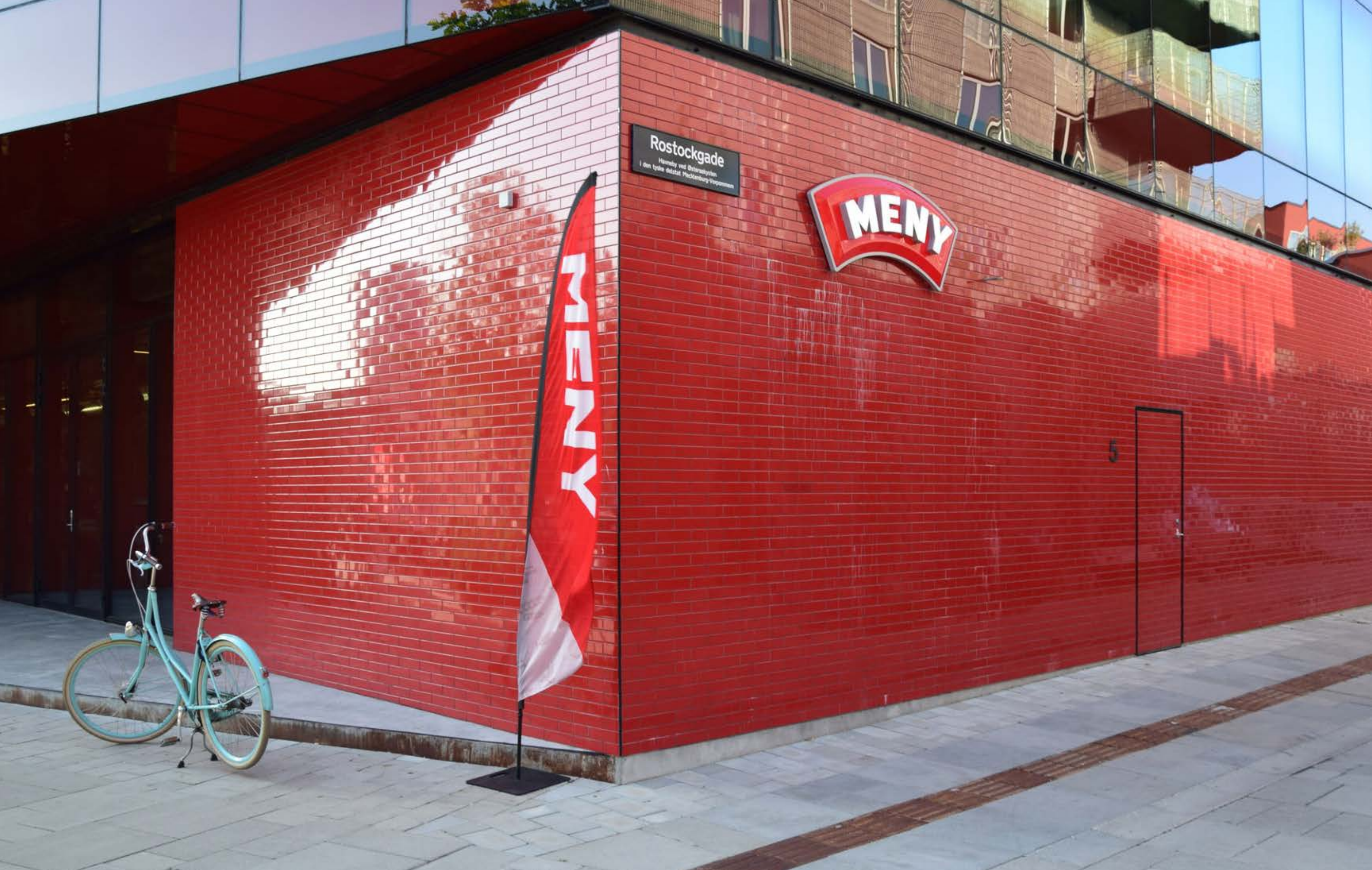
CENTRO COMMERCIALE MENY, COPENAGHEN - DANIMARCA
